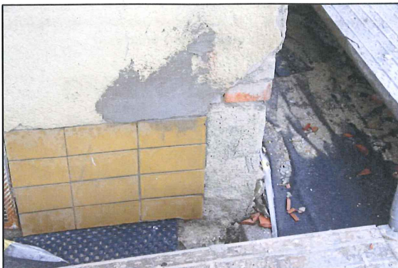
Detailní pohled na odpadlý sokl na jihovýchodním rohu objektu. Byla odstraněna jen nesoudržné obklady.
