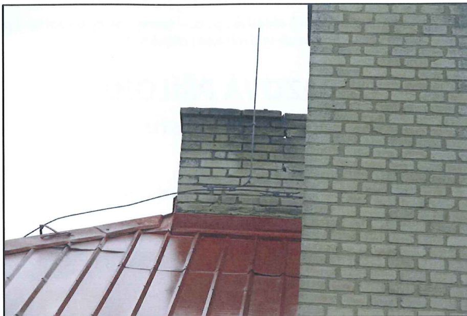
Pohled od jihu, ze kterého jsou patrné i díry ve zdivu, velmi špatný stav kominové hlavy (odpadlé kusy betonu) i samotného zdiva komínu.
