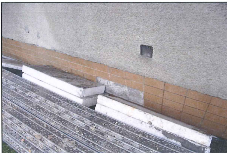
Sokl na východní straně objektu. Plocha nesoudržnosti se projevila při manipulaci na stavbě a přípravě podkladů pro zateplení.
