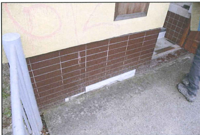
Sokl na severní straně zádveří (jiné obklady, barva i textura). Nesoudržnost obklady na podkladu zřejmě způsobila vlhkost a mráz. Nesoudržné obklady byly odstraněny.
